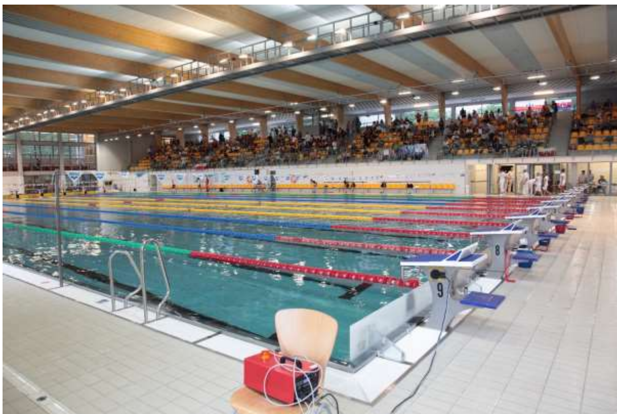
Fot. 3: Niecka basenu pływalni olimpijskiej w Gliwicach
