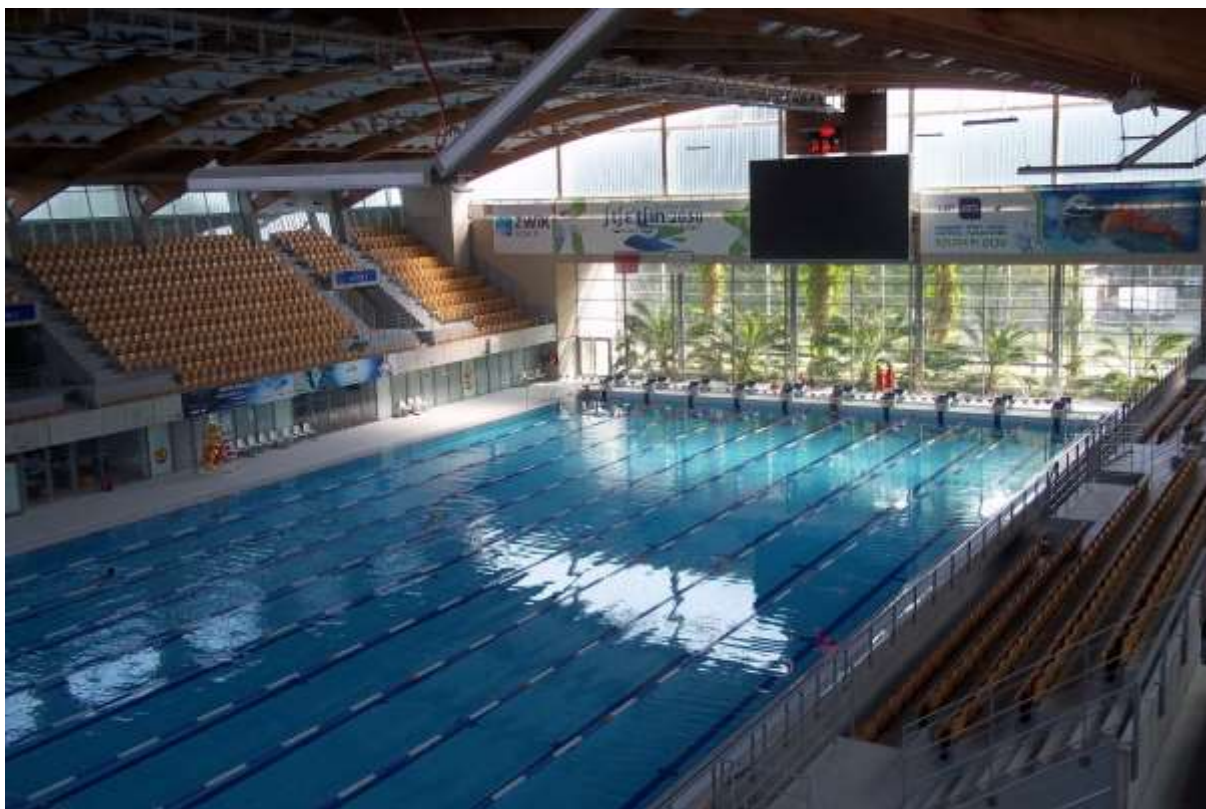
Fot. 11: Niecka basenu pływalni olimpijskiej w Szczecinie
